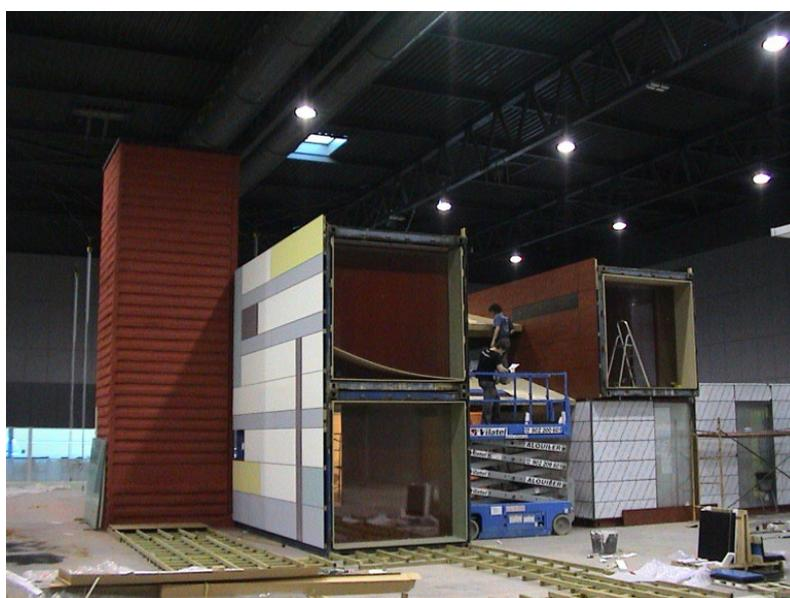
**Figura 7.** Después de colocar los 6 módulos de *R4House* parcialmente fabricados, la construcción se completó en dos semanas
