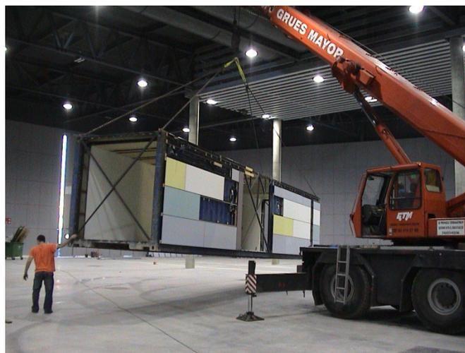
**Figura 5.** Cada módulo *R4House* se fabricó parcialmente por separado
