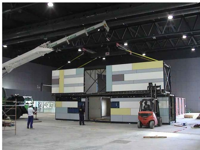
**Figura 6.** Los 6 módulos parcialmente fabricados se ensamblaron en solo un día
