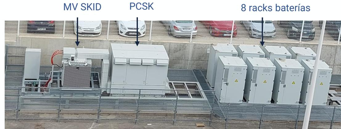
Acoplamiento DC: HEMK + DCDC + Baterías
