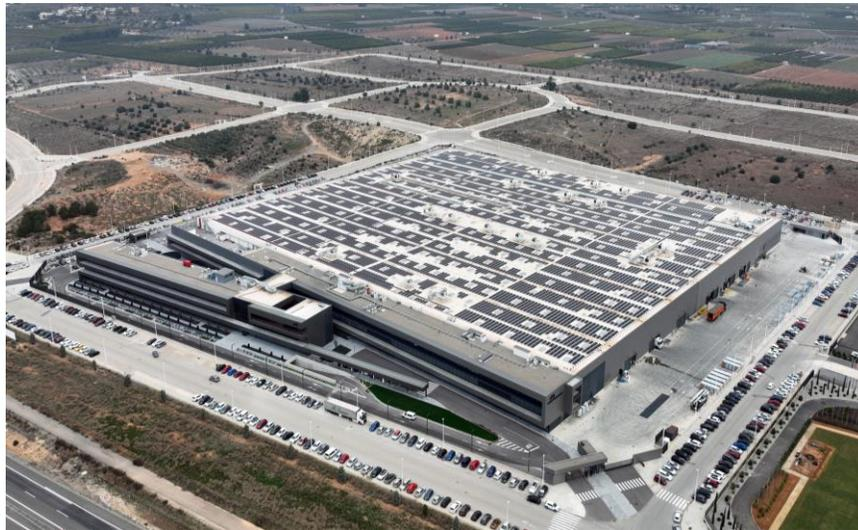
Instalación fotovoltaica sobre la cubierta de Power Electronics de 3600 kWp con módulos de 545W y una tensión máxima de 1500 V.
