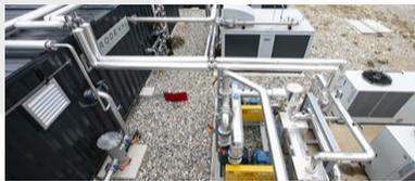
Secado y soplado de biogás
