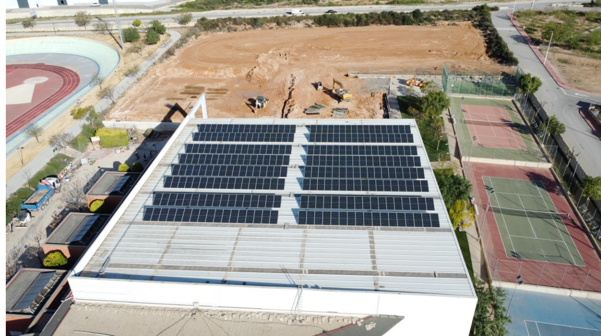
Polideportivo Félix Candela (cubierta) (120 kW)
