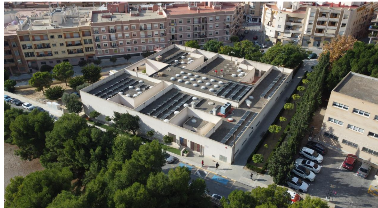
Centro de Personas Mayores (cubierta) (120 kW)
